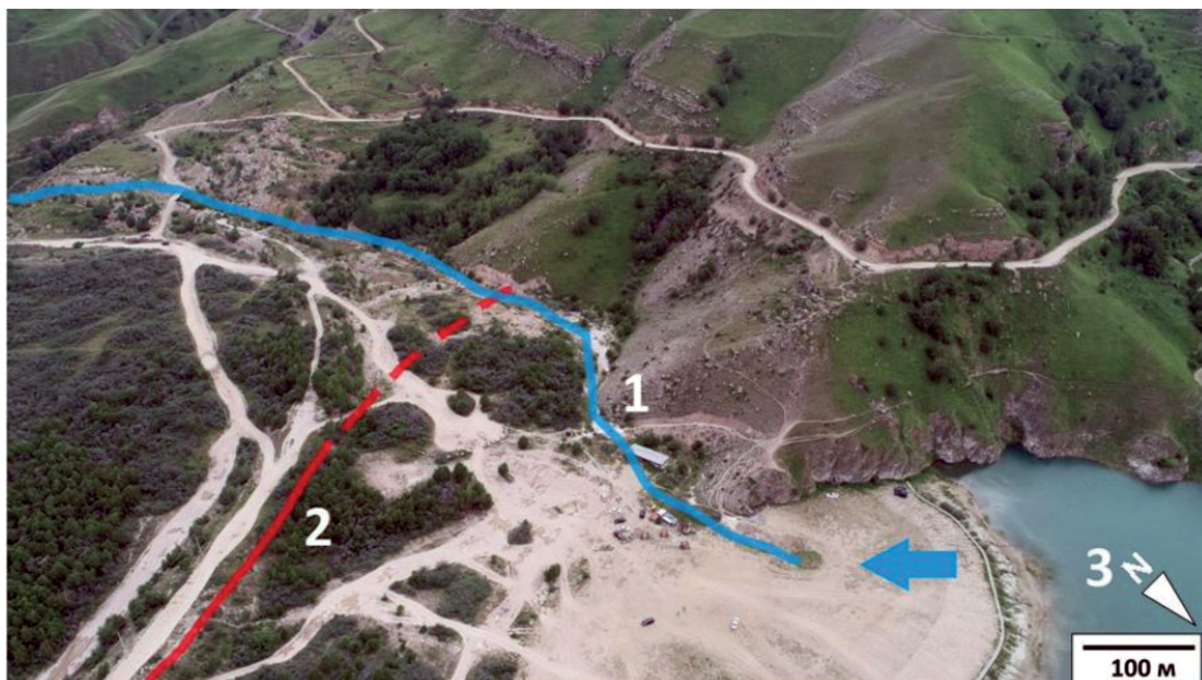
Рис. 5. Участок сопряжения отсечной дамбы и открытого аварийного водоотводного канала: 1 — русло аварийного водосброса; 2 — отсечная дамба (пунктиром обозначен участок, нуждающийся в доработке); 3 — водоем-отстойник хвостохранилища (стрелкой показано направление движения потока в случае переполнения водосборника). Фото с квадрокоптера ГУ МЧС России по КБР 19.06.2025
