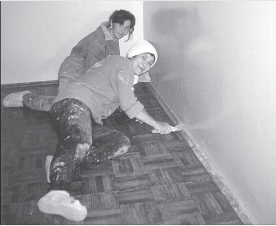
Последние мазки косметического ремонта
