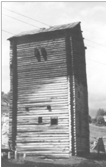
Водоподъемная башня над Октябрьской скважиной. Фото П. Юхтанова
